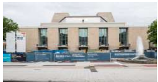
Sanierung Bühnen Köln
